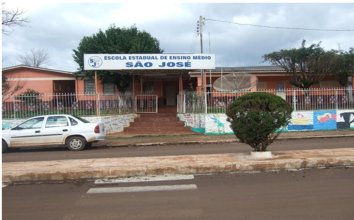
Figura 6 : Foto demonstrando vista parcial da Escola Estadual de Ensino Médio São José, Ponte Preta.
